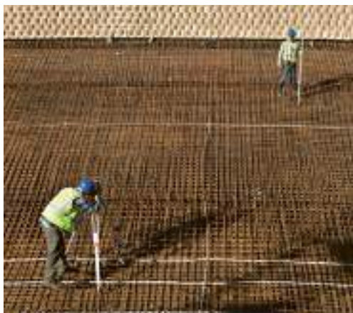
Des géomètres utilisant un théodolite : instrument mesurant des angles dans les deux plans horizontal et vertical, afin de déterminer une direction et des distances.
